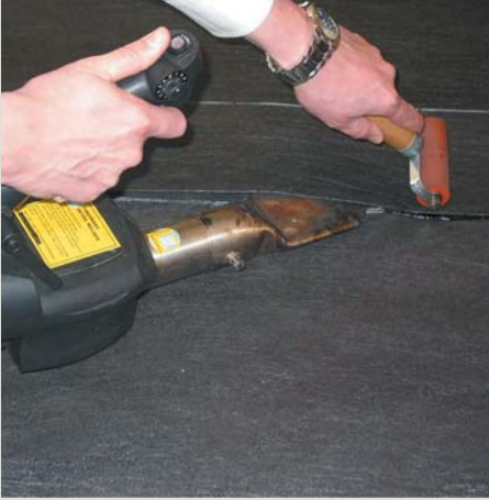
Lassen met behulp van hete lucht (verwarming met een combinatie van electra en gas)
