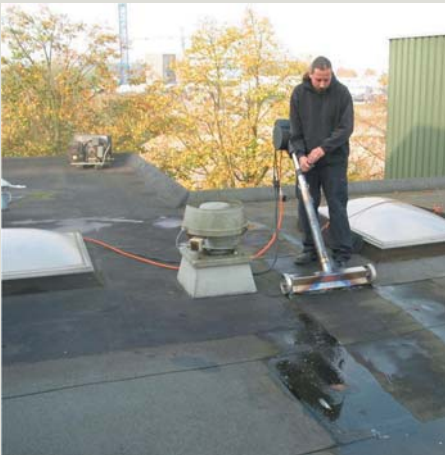
Drogen van dakbedekking met luchtmes
