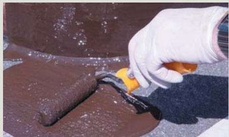
Detailafwerking met vloeibare dakbedekking
