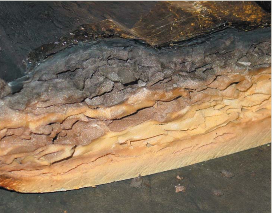
Vorming van isolerende koollaag op PIR isolatie
