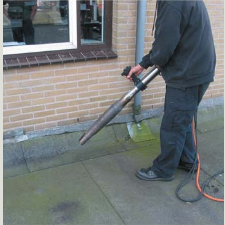
Drogen van dakbedekking met hete lucht
