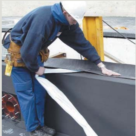
Uitvoering dakdetail zonder open vuur
