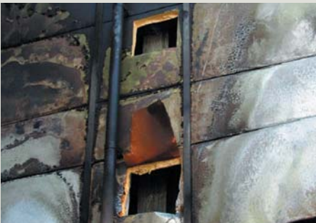
Zijkant van het gebouw (Foto 2)
